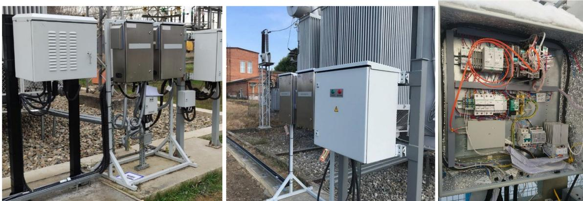
Рисунок 2. Исполнение шкафа сбора данных ШСД
