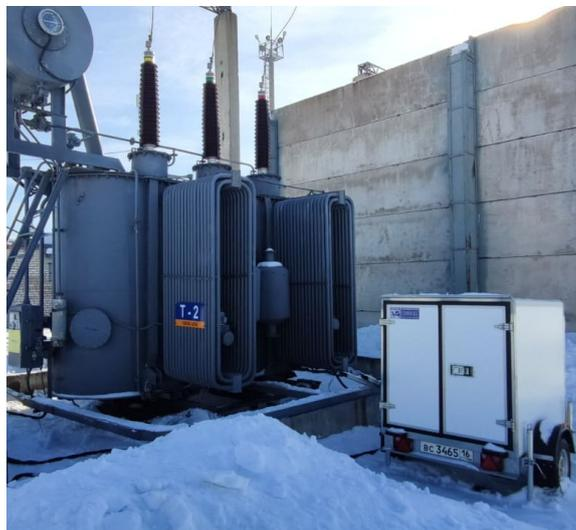
Мобильная автоматизированная система мониторинга
