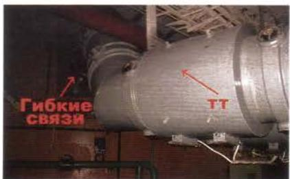
Рис. 31. Месторасположение трансформаторов тока для фазы С, где были зафиксированы наиболее сильные разряды
