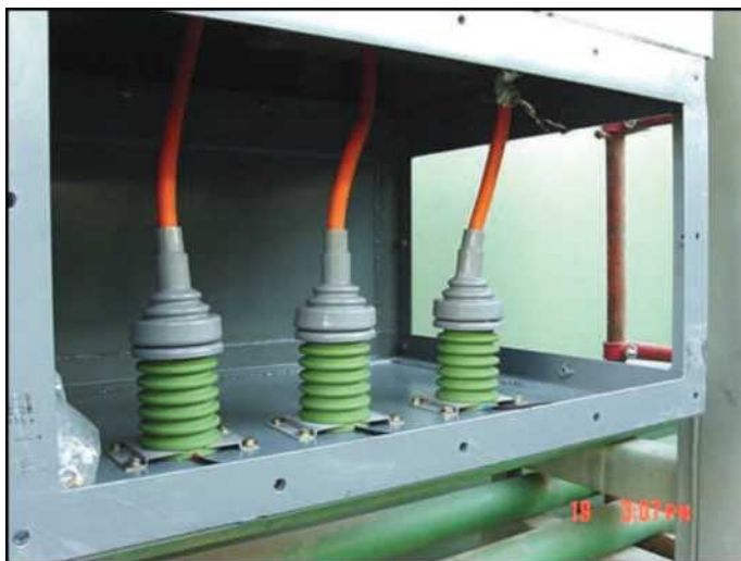
Установленные емкостные датчики
