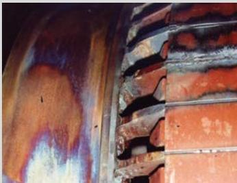
Повреждение сердечника ротора из-за сломанных стержней
