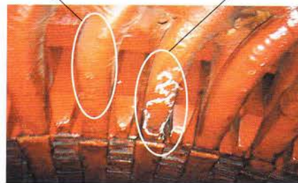
Рис. 5. Вспучивание и растрескивание изоляции обмотки статора электродвигателя ЭГПА
