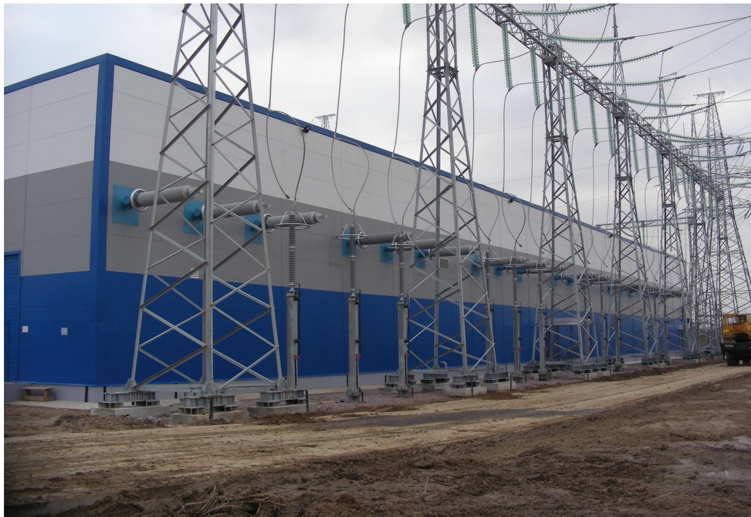
КРУЭ- 220 кВ и вводы «элегаз-воздух» ПС 330 кВ Южная СПб.
