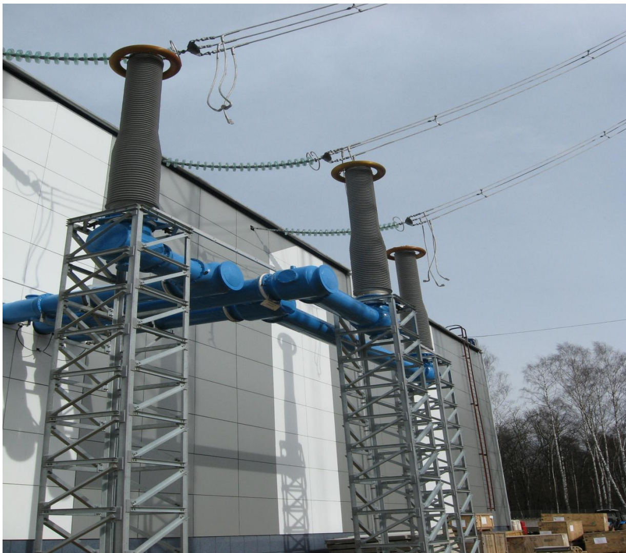
Элегазовый токопровод КРУЭ-ВЛ 500 кВ ПС 500 кВ Западная
